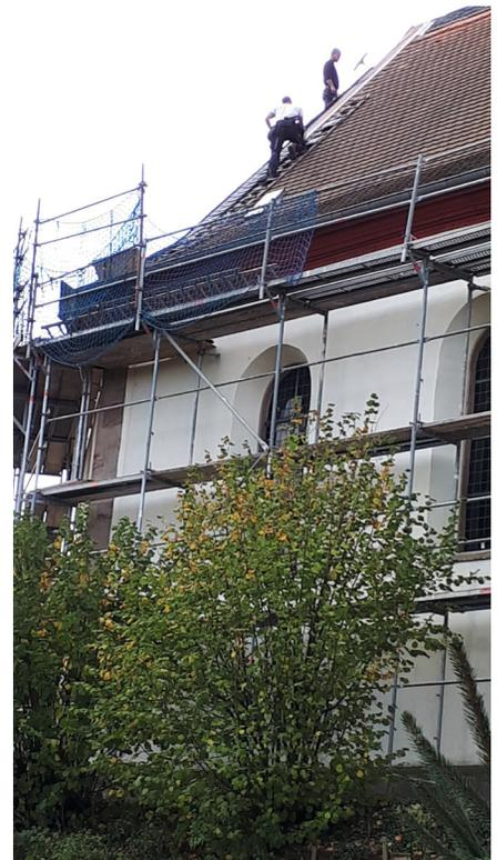
Aber nicht die Wasserflecken im Inneren waren das Problem, sondern die Dachkonstruktion und das Gesims in den Ecken des Chores waren bereits stark geschädigt. Auch hatte das eindringende Wasser bereits die Dachbalken angegriffen und erste Fäule war zu beobachten.
